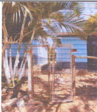
SUSTITUCIÓN DE PORTÓN DE METAL
