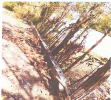
REPARACIÓN DE MURO PERIMETRAL DE BLOCK CON TUBO HG Y MALLA GALVANIZADA, SOLERAS INTERMEDIAS Y COLUMNAS
