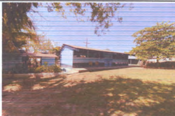
PINTURA EN MUROS EXTERIORES E INTERIORES
