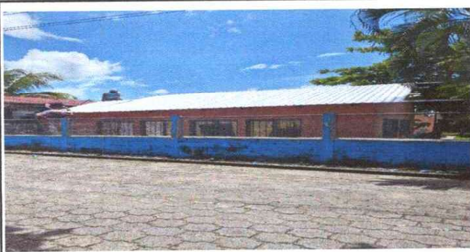
Construcción de los que será un Muro Perimetral de calidad que brinde seguridad a la comunidad educativa
