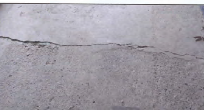
Foto 6: Torta de cemento en mal estado al ingreso del establecimiento.
