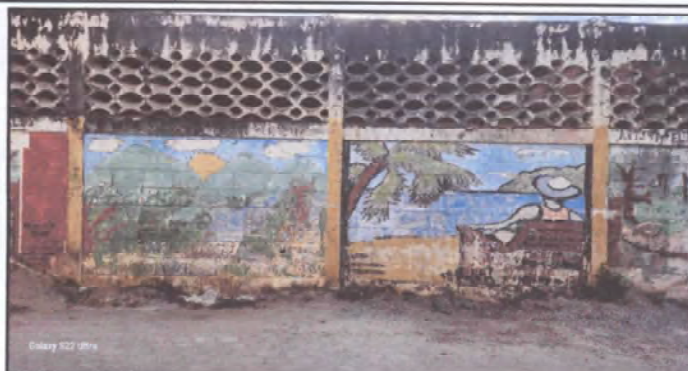
Foto 8: Muro perimetral en mal estado con requerimiento de pintura.
