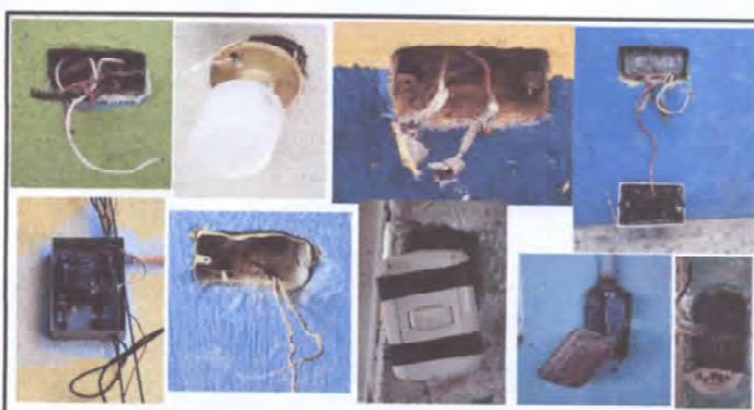
Foto 10: Tomacorrientes, Plafoneras, Interruptores en mal estado en la mayoría de salones y áreas del establecimiento.
