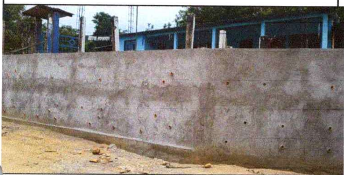
REPARACION EN MURO DE CONTENCIÓN
