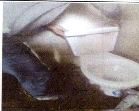
SUSTITUCIÓN DE SANITARIOS 3 SERVICIOS
