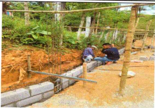
REPARACION EN MURO DE CONTENCIÓN
