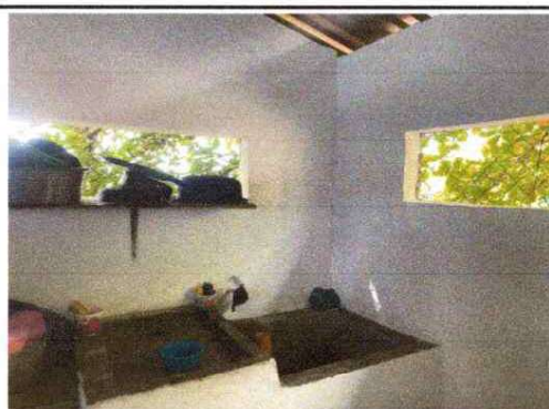
FOTO 10. Repello en muros
