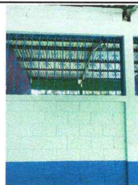
FOTO 4. Mantenimiento a balcones de metal.
