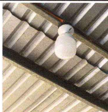
FOTO 8. Sustitución de plafoneras y focos ahorradores
