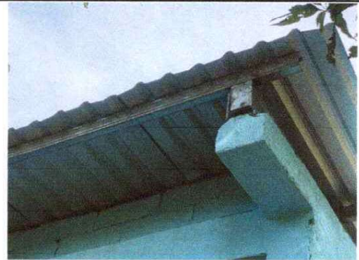
FOTO 2 . Sustitución de estructura de metal negro por metal galvanizado
