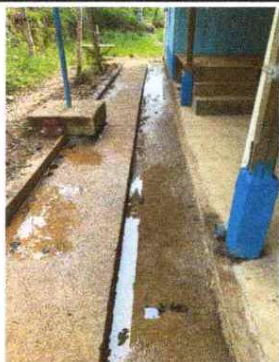
FOTO 7. Reparación de plancha de concreto en patio.
