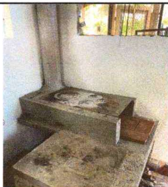
FOTO 9. Reparación de cocina
