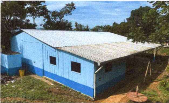
FOTO 1. sustitución de lámina de zinc por lámina troquelada aluzinc calibre 26
