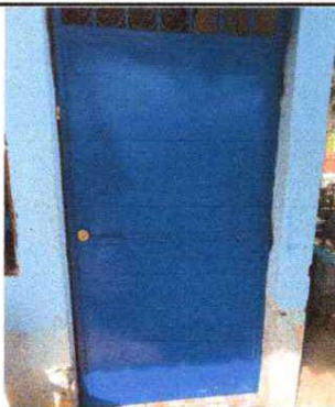
FOTO 3. Sustitución de puerta de metal
