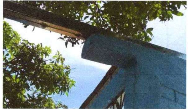
FOTO 2. Sustitución de estructura de metal negro por metal galvanizado
