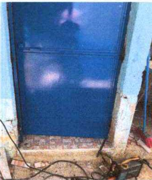
FOTO 3. Sustitución de puerta de metal
