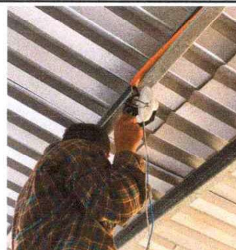
FOTO 8. Sustitución de plafoneras y focos ahorradores
