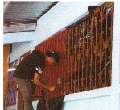
FOTO 4. Mantenimiento a balcones de metal.
