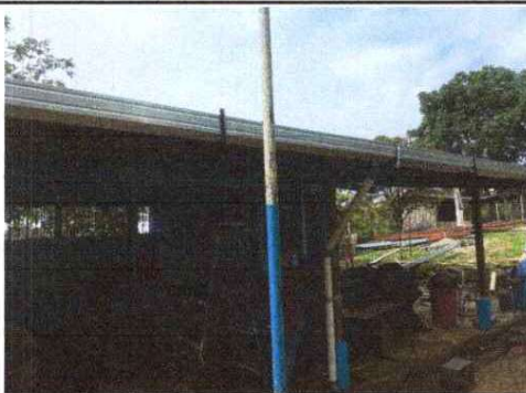
FOTO 5. Sustitución de canal de pvc, pescante del canal y la bajada
