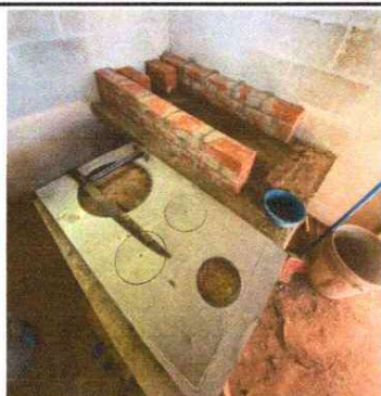
FOTO 9. Reparación de cocina
