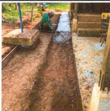
FOTO 7. Reparación de plancha de concreto en patio.
