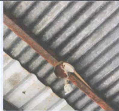
FOTO 8. Sustitución de plafoneras y focos ahorradores
