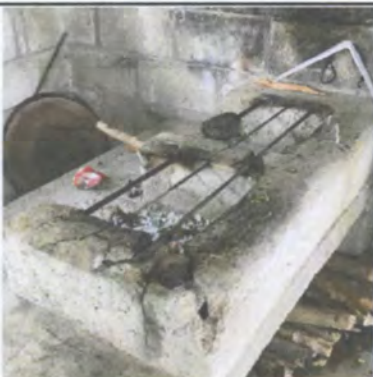
FOTO 9. Reparación de cocina
