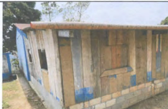
FOTO 5. Sustitución de canal de pvc, pescante del canal y la bajada
