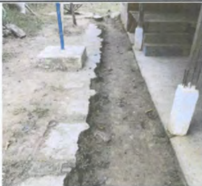
FOTO 7. Reparación de plancha de concreto en patio.
