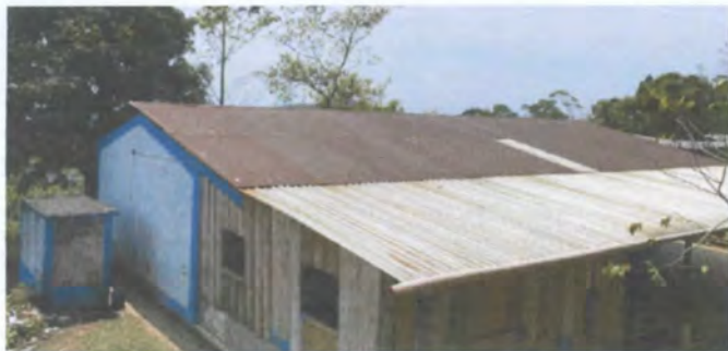
FOTO 1. sustitución de lámina de zinc por lámina troquelada aluzinc calibre 26
