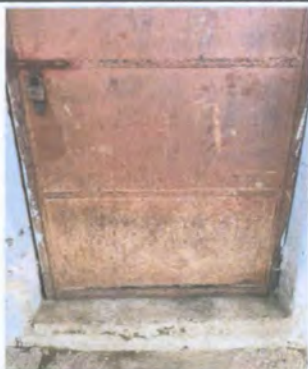
FOTO 3. Sustitución de puerta de metal
