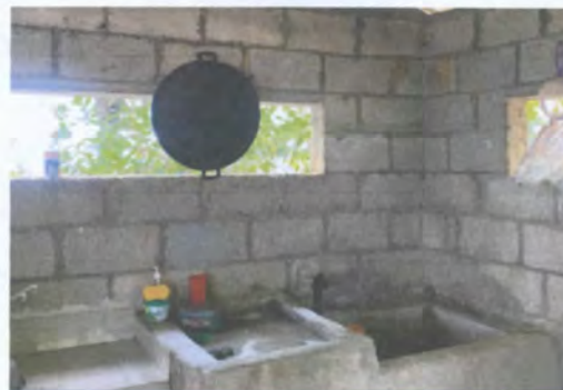
FOTO 10. Repello en muros
