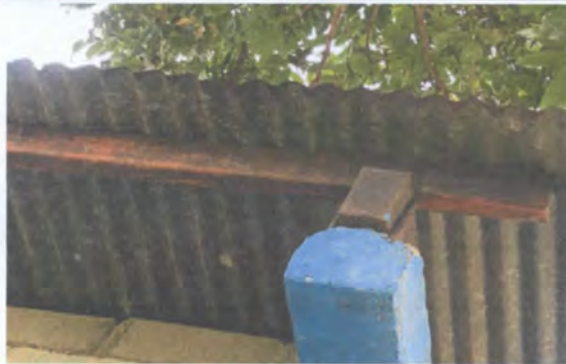
FOTO 2. Sustitución de estructura de metal negro por metal galvanizado
