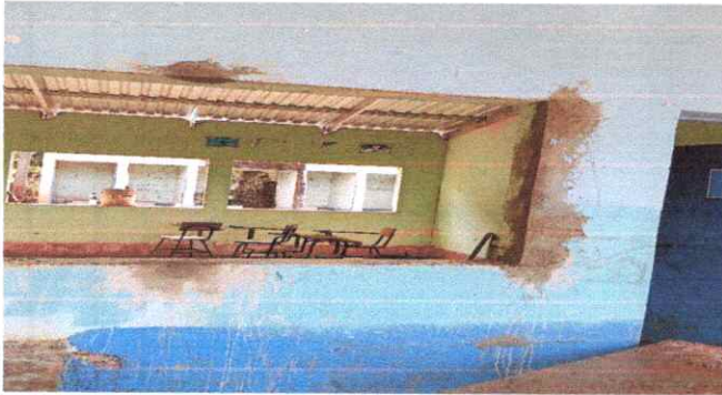
5 VENTANAS 5.6 SUSTITUCION DE BALCONES DE METAL
