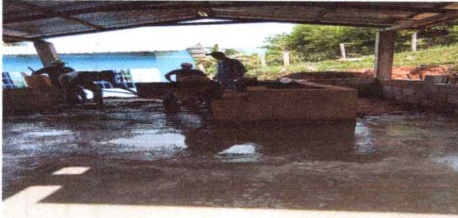
REPARACION DE PISO DE TORTA DE CEMENTO
