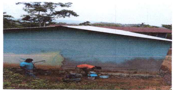
6 PINTURA EN MUROS EXTERIORES Y SUS INTERIORES
