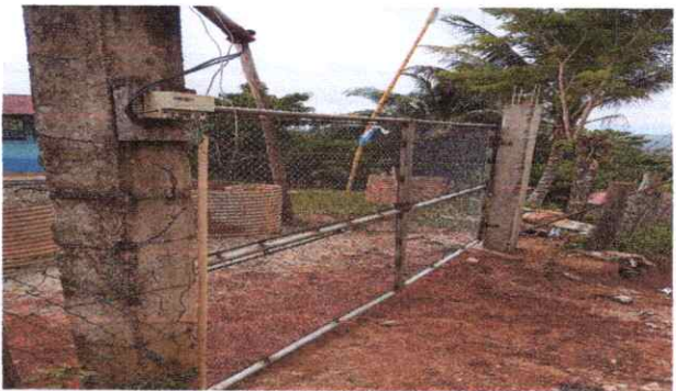
12 MANTENIMIENTO DE PORTONES DE METAL
