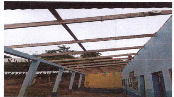
1 CUBIERTA DE LAMINA Y 2 ESTRUCTURA DE TECHO
