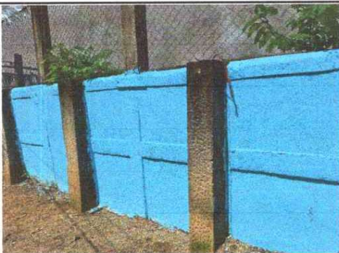
Muro de contención
