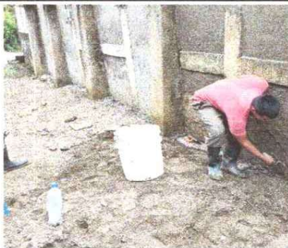
Muro de contención
