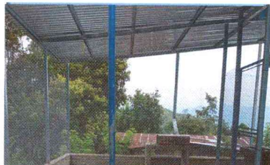
ESTRUCTURA DE TECHO
