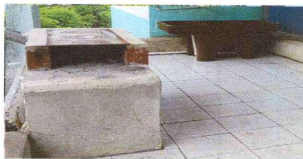
REPARACION DE COCINA
