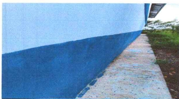
PINTURA EN MUROS EXTERIORES E INTERIORES
