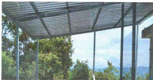
CUBIERTA DE LAMINA
