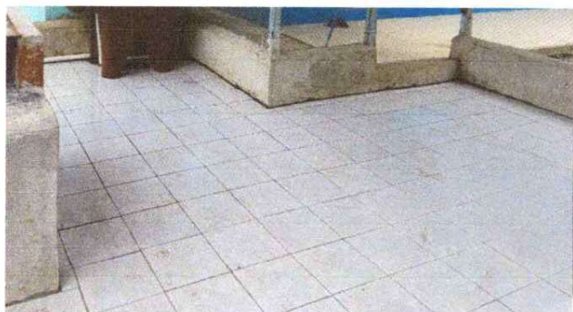
SUSTITUCION DE TORTA DE CONCRETO
