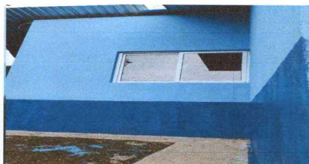
PINTURA EN MUROS EXTERIORES E INTERIORES
