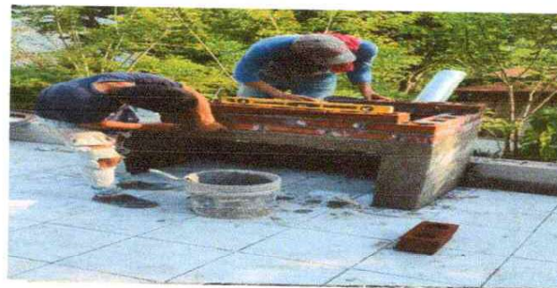
REPARACION DE COCINA
