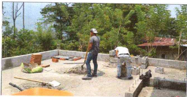
SUSTITUCION DE TORTA DE CONCRETO
