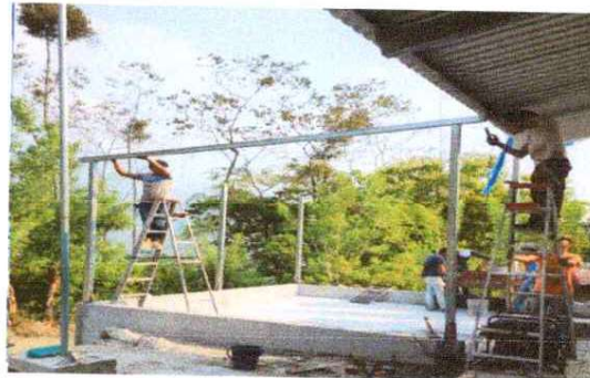
ESTRUCTURA DE TECHO
