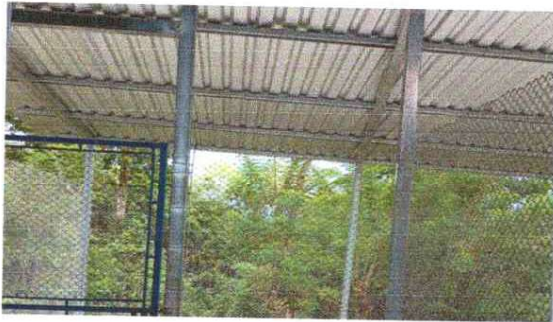
CUBIERTA DE LAMINA
