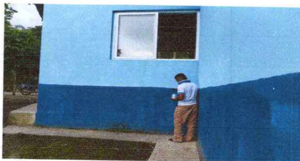
PINTURA EN MUROS EXTERIORES E INTERIORES
