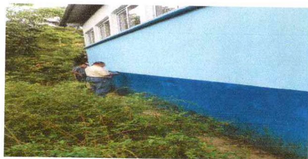
PINTURA EN MUROS EXTERIORES E INTERIORES
