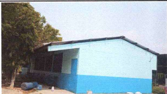
Foto 5: pintura en muros exteriores
