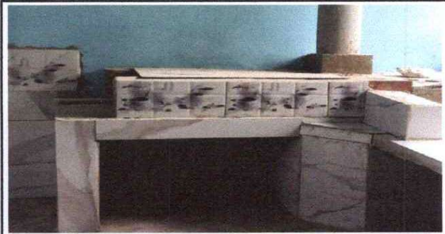
Foto 6: sustitución de estufa rural completa
