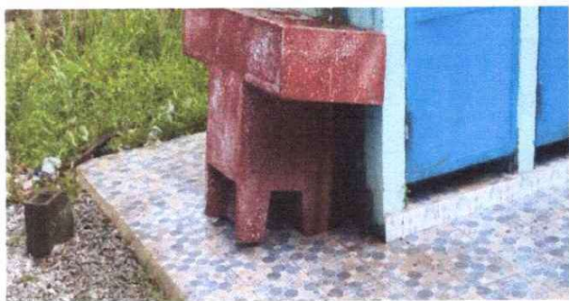
Foto1: sustitucion de pila de 2 lavadores
