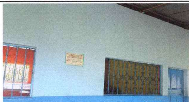
Foto 6: mantenimiento a Balcones
