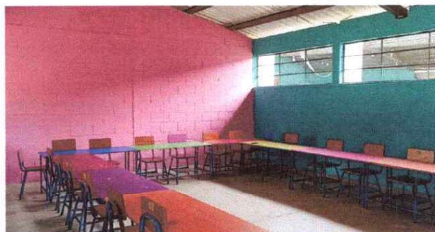
Foto 4: pintura en muros interiores
