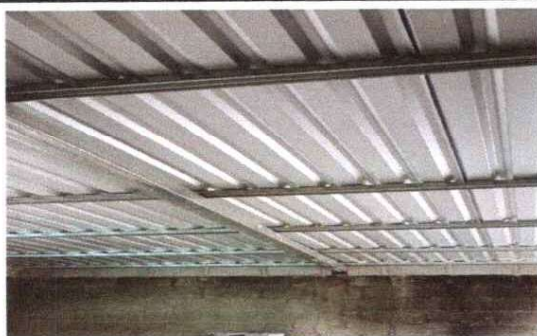
Foto1: cubierta de lamina para cocina
