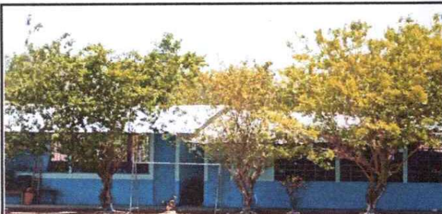
Foto 3: cubierta de lamina en modulo de aulas
