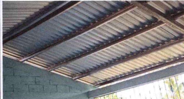
Foto 2: cubierta de lamina para modulo de aulas
