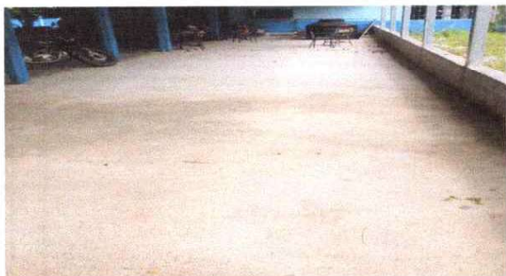
Foto 3: reparación de piso de torta de concreto en salón
