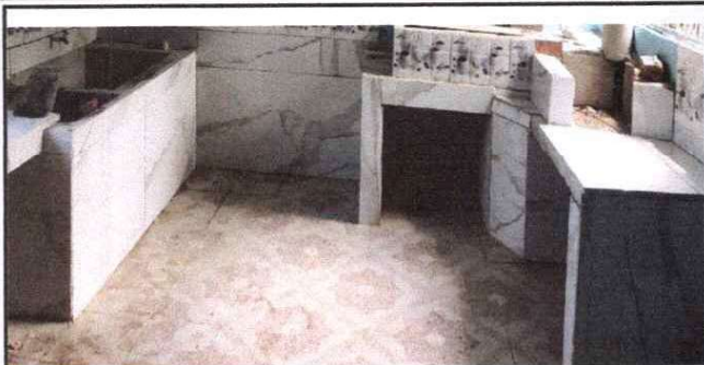
Foto 1: reparación de piso de torta de concreto en cocina
