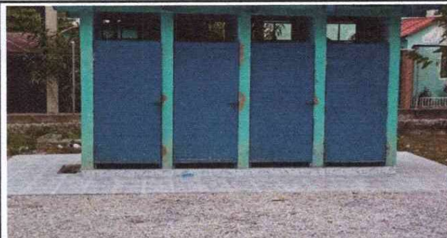
Foto 2: reparación de piso de torta de concreto en baños
