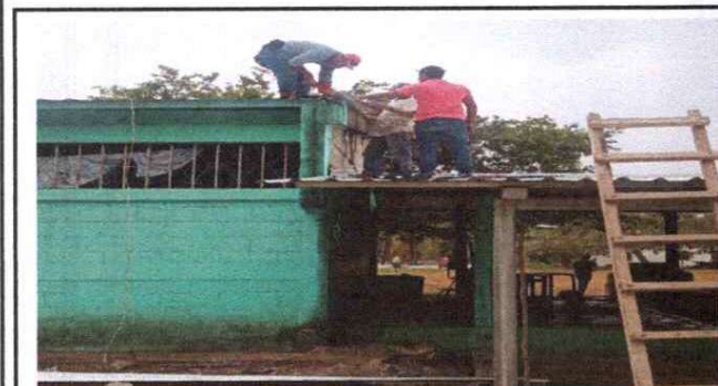
Foto 3: cubierta de lamina en modulo de aulas
