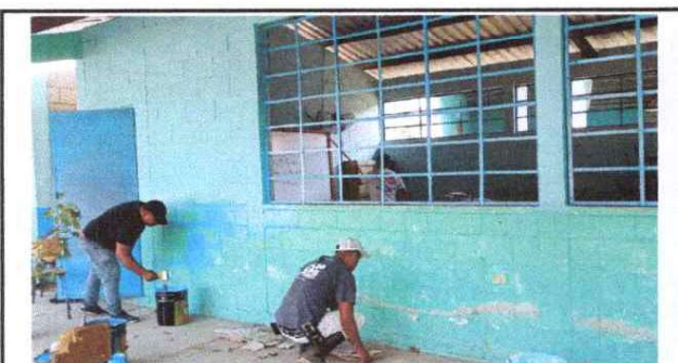
Foto 5: pintura en muros exteriores
