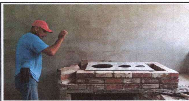
Foto 6: sustitución de estufa rural completa
