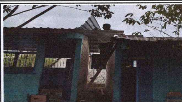
Foto 2: cubierta de lamina para modulo de aulas
