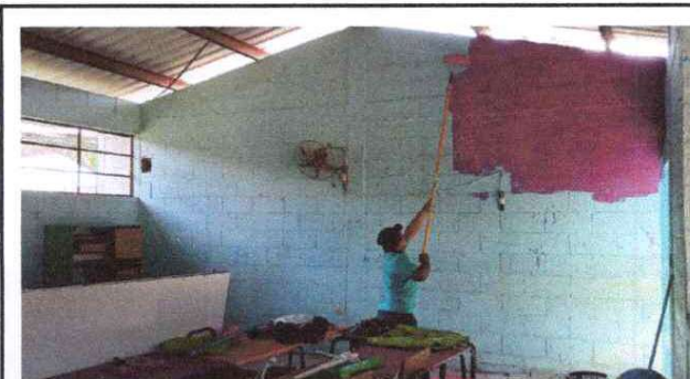
Foto 4: pintura en muros interiores
