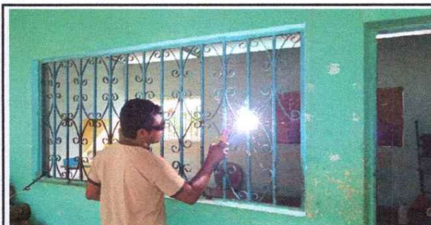
Foto 6: mantenimiento a Balcones
