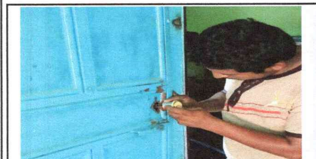
Foto 5: sustitucion de chapa en Direccion de la Escuela
