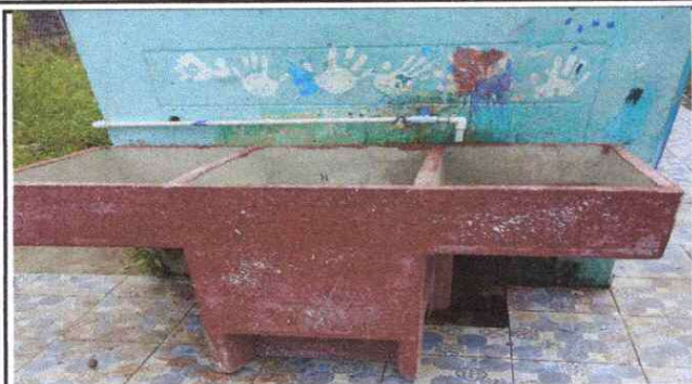
Foto1: sustitucion de pila de 2 lavadores
