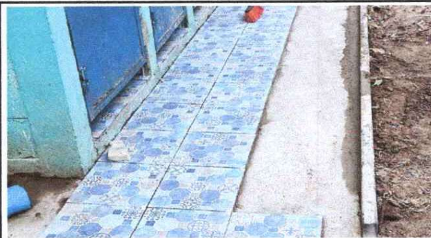
Foto 2: reparación de piso de torta de concreto en baños
