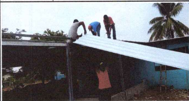
Foto1: cubierta de lamina para cocina
