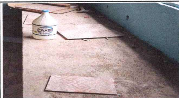
Foto 1: reparación de piso de torta de concreto en cocina
