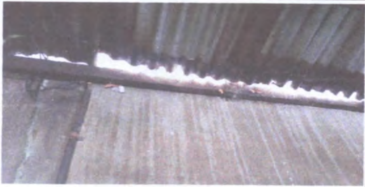
foto 1 cubierta de lamina para cocina,
