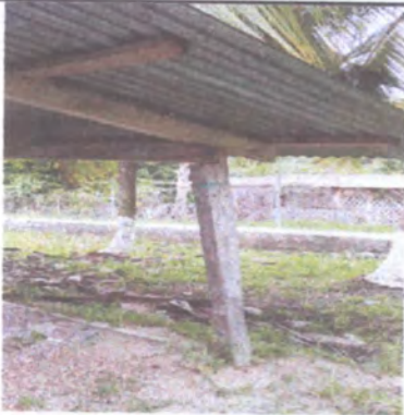
foto 4 sustitucion de estructura de soporte de madera por metal
