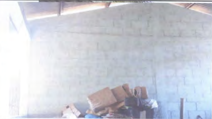
foto 10 pintura en muros interiores
