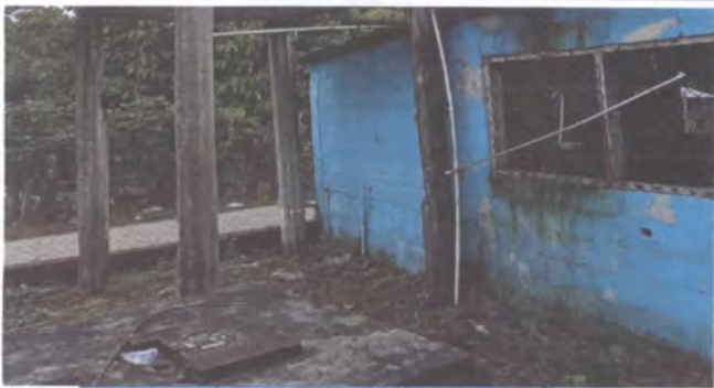
foto 11 pintura en muros exteriores
