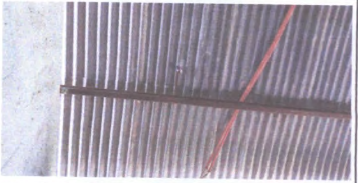
foto 2 cubierta de lamina para modulo de aula
