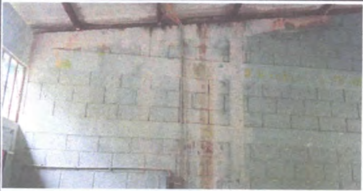
foto 3 cubierta de lamina en modulo de aula
