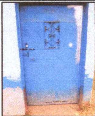
SUSTITUCIÓN DE PUERTA (COCINA)
