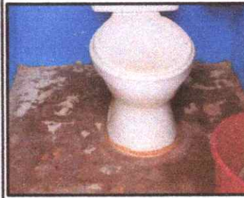
SUSTITUCIÓN DE PISO CERAMICO (ANTIDESLIZANTE EN SANITARIOS Y DUCHAS)
