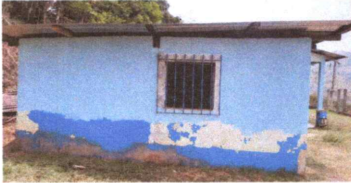
REPELLO EN MURO (COCINA)
