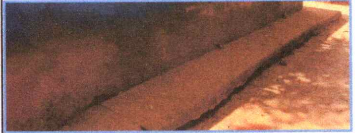
SUSTITUCIÓN DE PLANCHA DE CONCRETO DE PATIO
