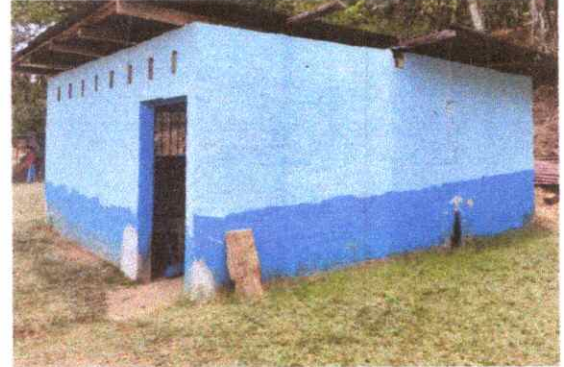
REPELLO EN MURO (COCINA)
