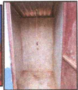
SUSTITUCIÓN DE PISO CERAMICO (ANTIDESLIZANTE EN SANITARIOS Y DUCHAS)
