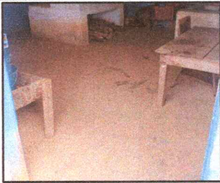
SUSTITUCIÓN DE PISO GRANITO (COCINA)
