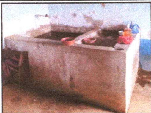
SUSTITUCIÓN DE AZULEJO EN PILA (COCINA)
