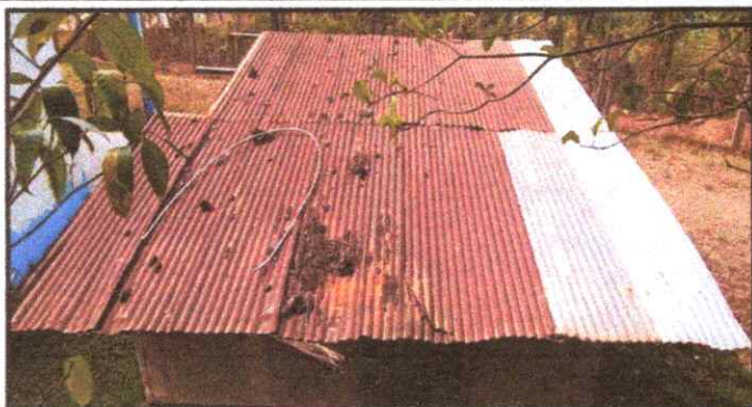
SUSTITUCIÓN DE LAMINA , POR LAMINA TROQUELADA ALUZINC CALIBRE 26 (COCINA)
