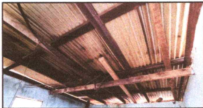
SUSTITUCION DE ESTRUCTURA SOPORTE DE MADERA, POR METAL (COCINA)
