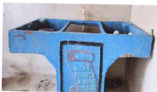
sustitución de pila de dos lavaderos (cocina)
