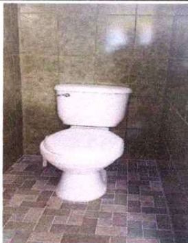
sanitario instalado con sus accesorios.
