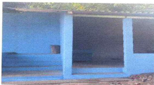
pintura en muros exteriores e interiores.
