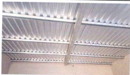
sustitución de lámina troquelada y estructura de metal (cocina)
