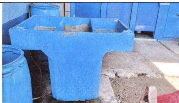
instalación de pila de dos lavaderos frente a sanitarios.
