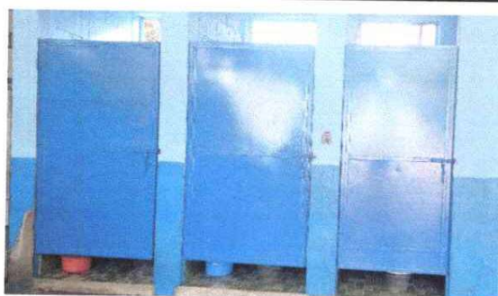
mantenimiento a estructura (lijado, cepillado, aplicación de pintura) puertas de sanitarios.
