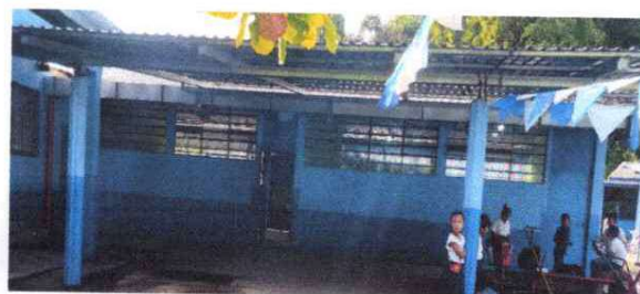
sustitución de estructura de soporte de metal y lámina troquelada. (galera frente a aulas)
