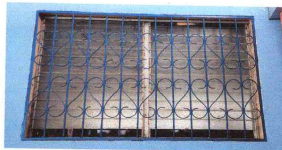
mantenimiento a balcones de metal.m
