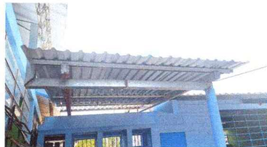
reparación de terraza y construcción de galera frente a terraza de sanitarios. (acta No. 17-2024)
