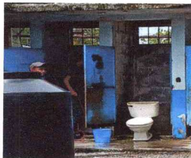
Desinstalación de sanitarios.
