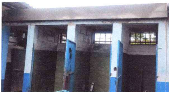
desinstalación de las puertas de metal de sanitarios para su lijado, cepillado, aplicación de pintura.
