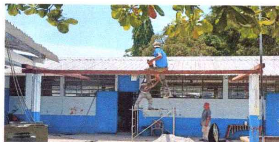
desinstalación de estructura de soporte de metal, ( galera frente a aulas)
