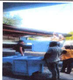
traslado de pilas de dos lavaderos, para la sustitución en cocina
