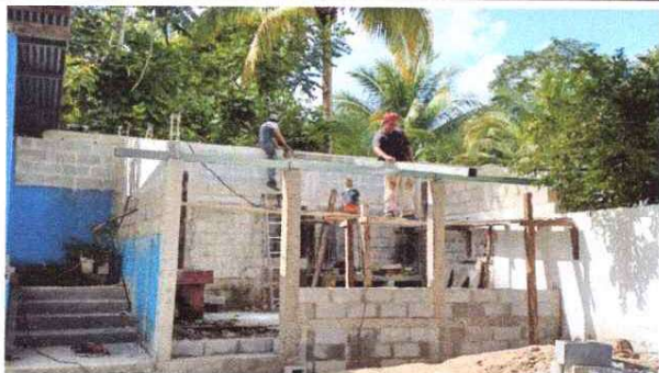
Instalación de estructura de metal, para la sustitución de lámina troquelada.
