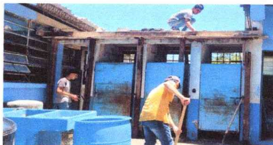
reparación de terraza de sanitarios.
