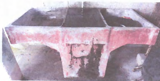
Sustitución de pila de dos lavaderos
