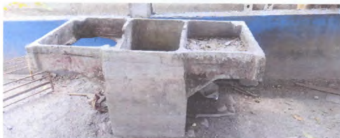
Sustitución de pila de dos lavaderos
