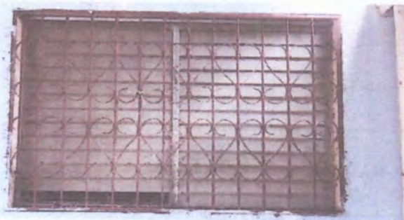
Mantenimiento a balcones de metal
