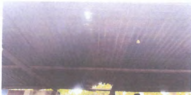
Sustitución de lámina troquelado aluzinc calibre 26
