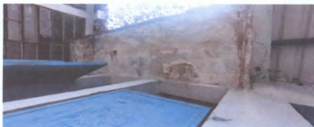
Impermeabilización de loza
