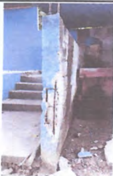
Pintura en muros exteriores e interiores
