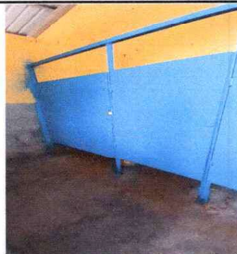
Foto 2: Reparación de Estructura en baños de Niñas
