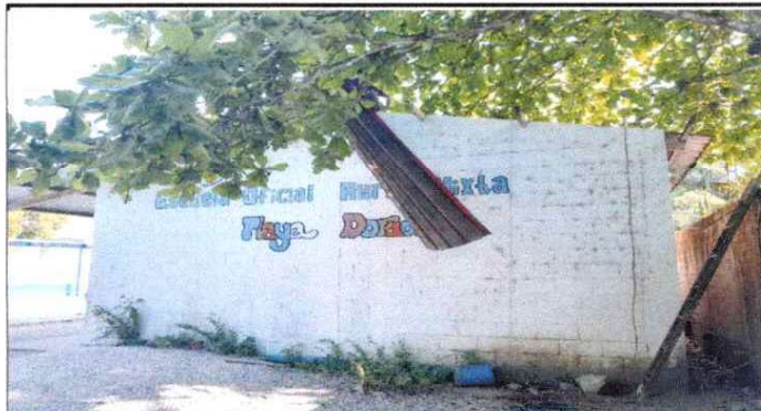
Foto 10: Cambio de Lámina en Aulas
