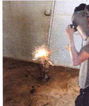
Foto 2: Reparación de Estructura en baños de Niñas
