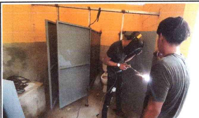
Foto 3: Cambio de estructura metálica de las divisiones de los sanitarios de varones y puertas
