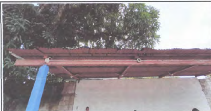
Foto 9: Cambio de lámina en escenario
