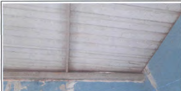
Foto 11: Cambio de Lámina en Aulas
