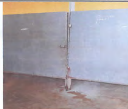
Foto 2: Reparación de Estructura en baños de Niñas
