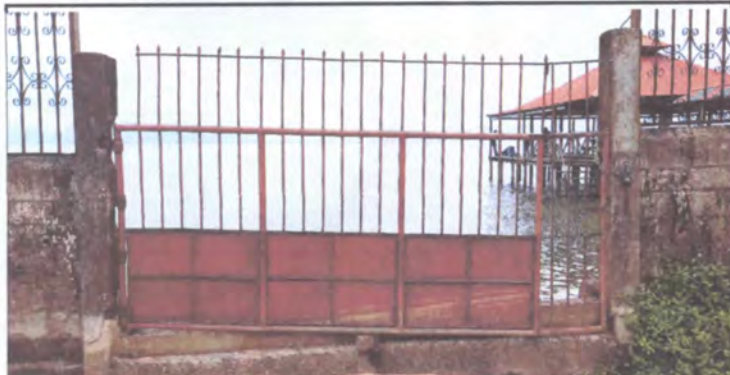
Foto 7: Cambio de Portón hacia el Lago
