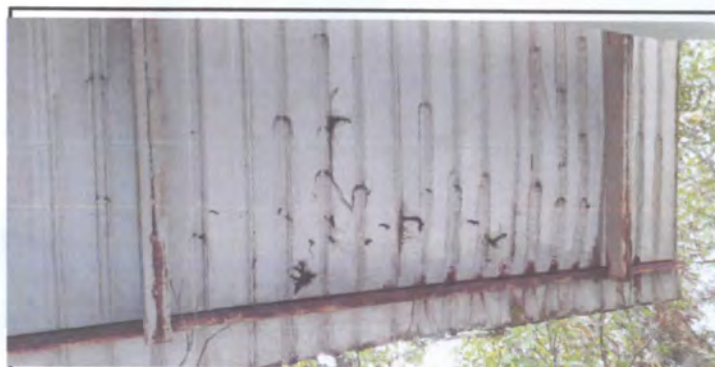
Foto 6: Cambio de lámina troquila y costatera.
