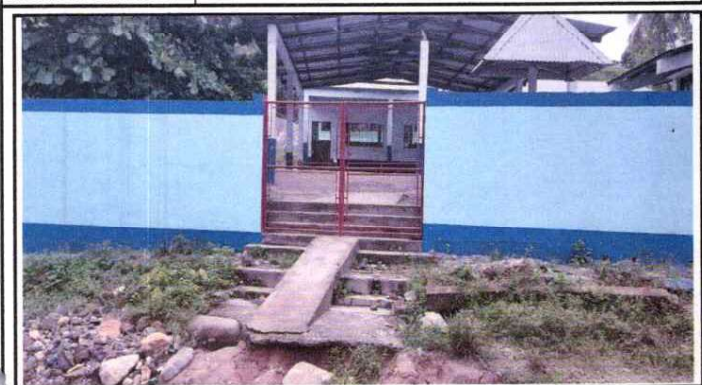
Reparación de muro perimetral
