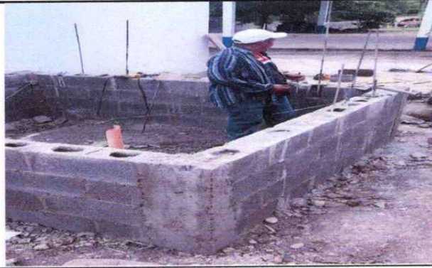
Sustitución de pila de cemento
