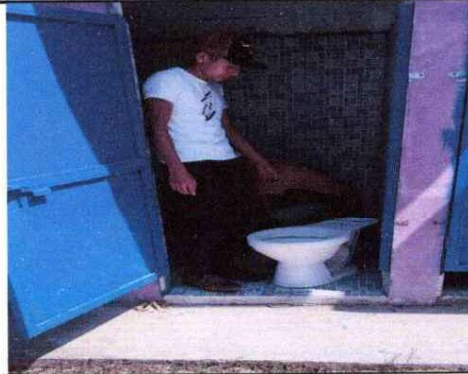
Sustitución de inodoro
