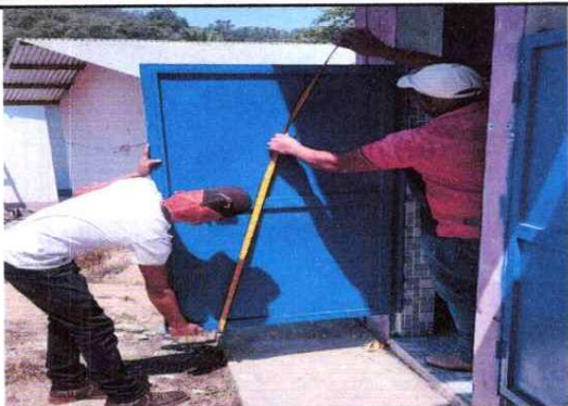
Sustitución de puertas en servicios sanitarios
