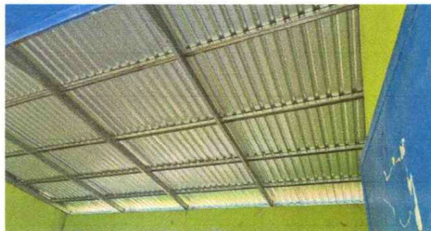
Cambio de estructura de madera a metal
