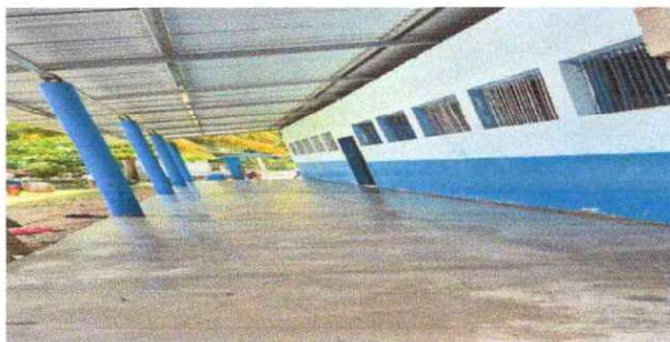
Sustitucion de torta de cemento
