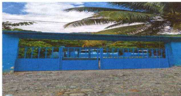
Mantenimiento a porton de metal
