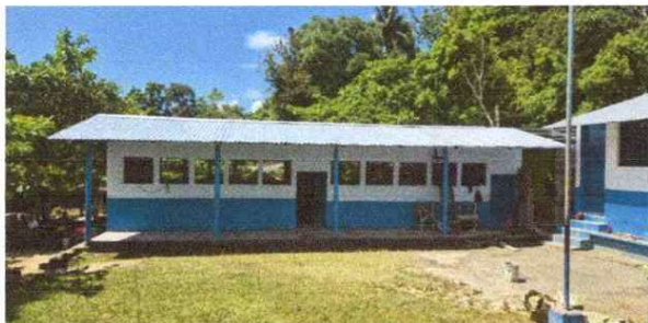
Sustitucion de cubierta de lamina
