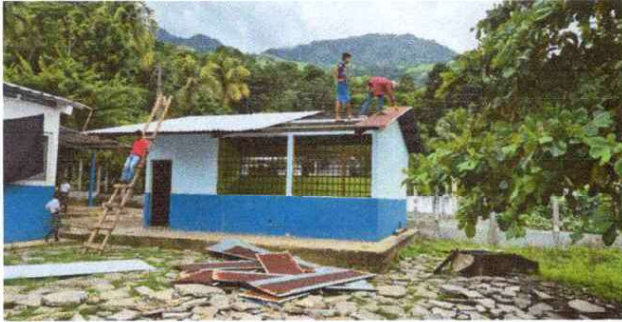
Sustitucion de cubierta de lamina
