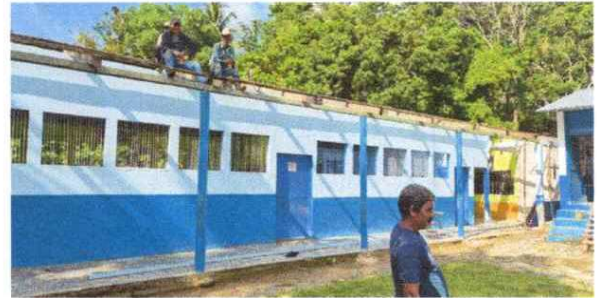
Cambio de estructura de madera a metal
