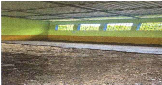
Sustitucion de torta de cemento
