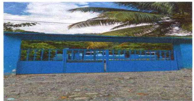
Mantenimiento a porton de metal
