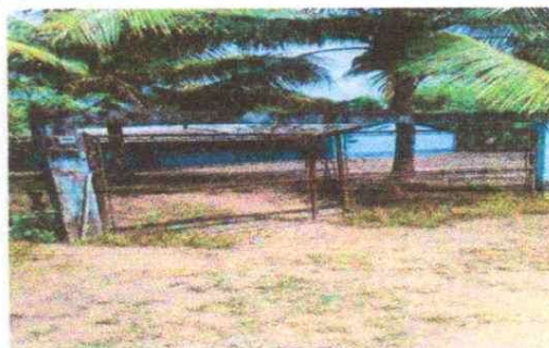
sustitución de porton
