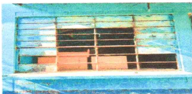
sustitución balcon de ventanas
