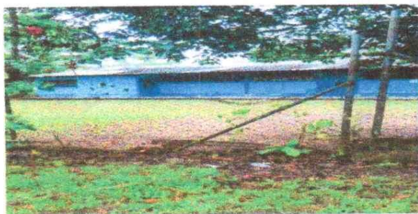
reparación de puro perimetral de block y malla
