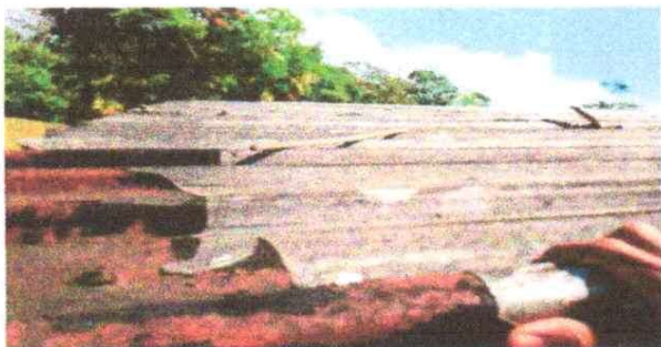
Sustitución de lamina por lamina troquelada
