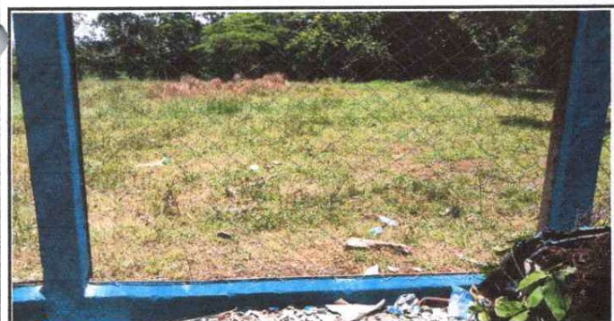
MALLA DE MURO REPARADA
