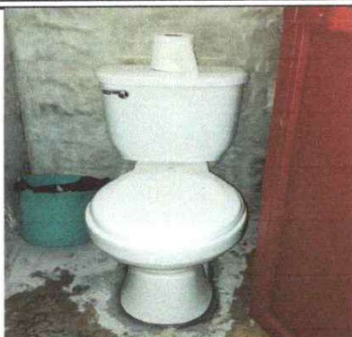
BAÑOS YA INSTALADOS, PUERTAS DE BAÑOS REMOZADAS
