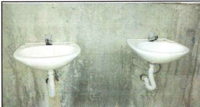
LAVAMANOS NUEVOS INSTALADOS
