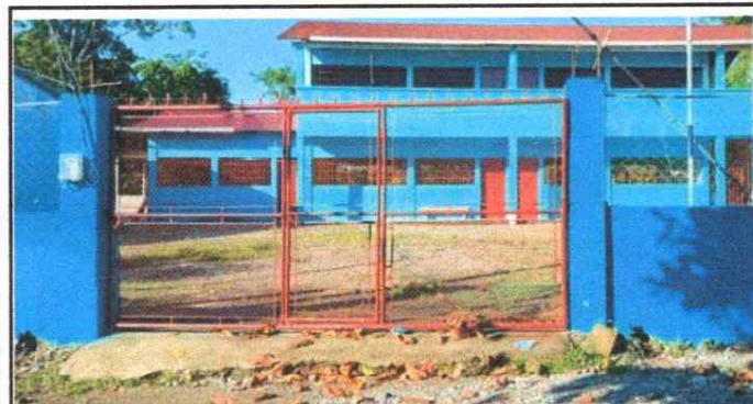
REPARACIÓN Y PINTURA EN PORTÓN
