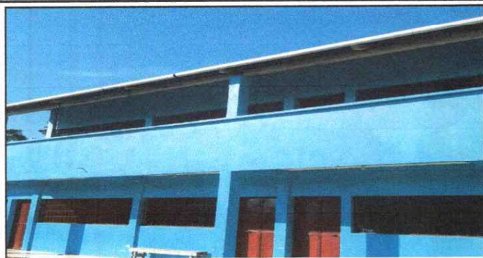
CANALETES NUEVOS INSTALADOS
