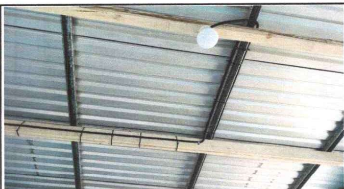
SISTEMA ELÉCTRICO NUEVO Y BOMBILLAS INSTALADAS
