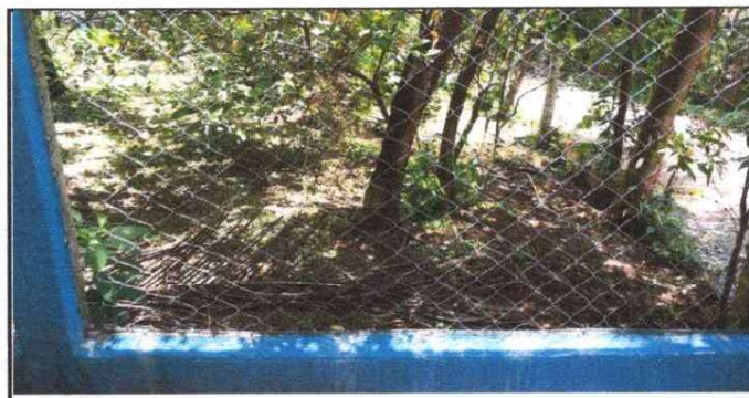
MALLA DE SERCA INSTALADA
