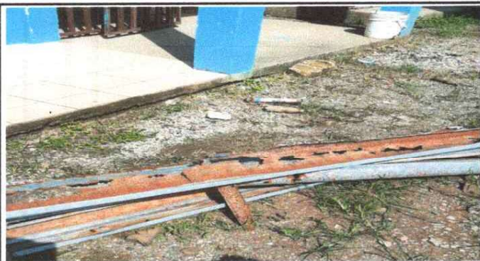
RETIRO DE CANALETES INSERVIBLES
