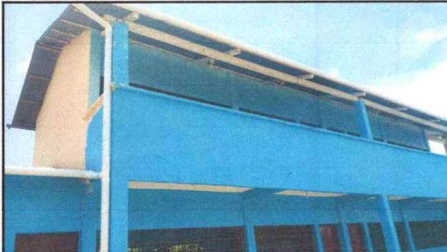
INSTALACIÓN DE LOS NUEVOS CANALETES Y BAJADA DE AGUA PLUVIAL
