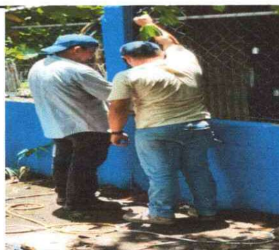
INSTALACIÓN DE MALLA EN LA SERCA.
