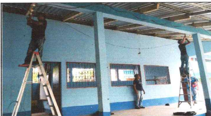
INSTALACIÓN DE SISTEMA ELÉCTRICO
