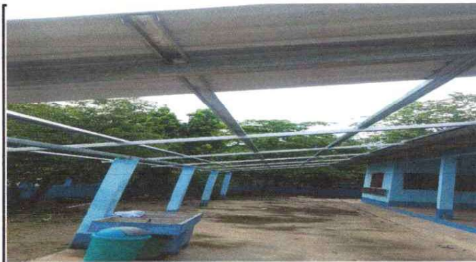
INSTALACIÓN DE ESTRUCTURA DE METAL Y LÁMINA NUEVA
