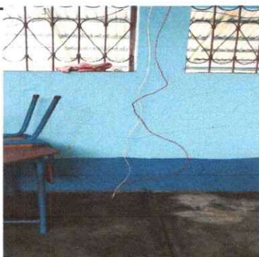
INSTALACIÓN DE TOMACORRIENTES
