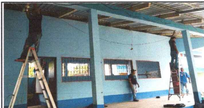
INSTALACIÓN DEL NUEVO CABLEADO
