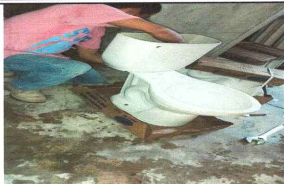
INSTALACION DE BAÑOS NUEVOS
