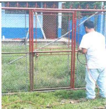
MANTENIMIENTO A PORTÓN
