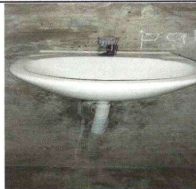
INSTALACIÓN DE LAVAMANOS NUEVOS
