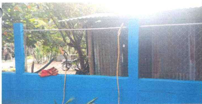
REPARACIÓN DE MALLA DE SERCA
