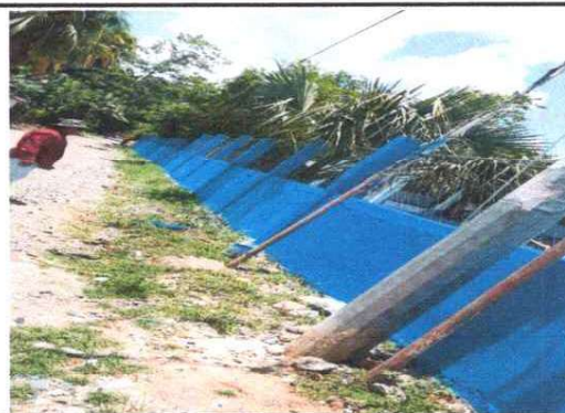
MANTENIMIENTO A MURO EXTERIOR E INTERIOR
