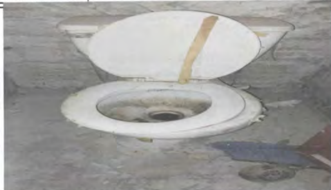
Sanitarios fuera de servicio
