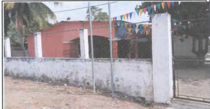
Situación de Muro Perimetral
