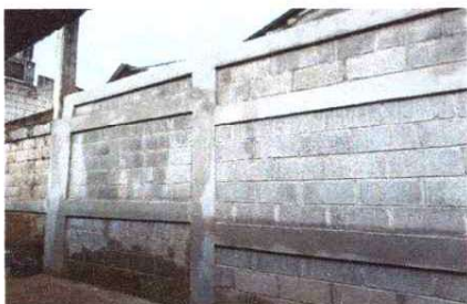
Foto1: MURO DE CONTENCIÓN
