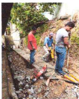
Foto1: MURO DE CONTENCIÓN
