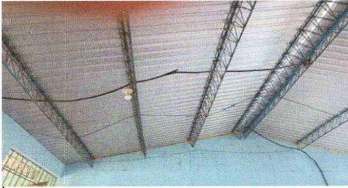
Foto1: Sustitución de lámina por lámina troquelada zinc calibre 26.
