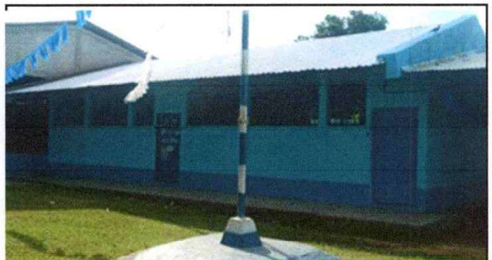
Foto 4: Pintura en muro exterior e interior
