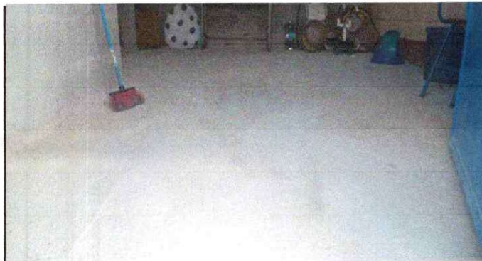
Foto 3: Sustitución de piso de concreto
