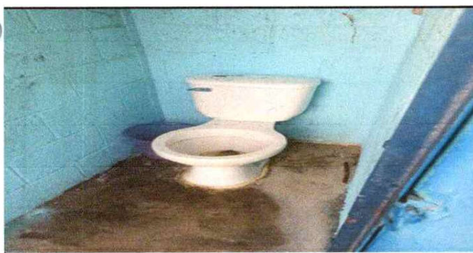
Foto 5: Sustitución de Baños
