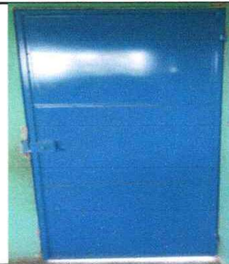
Foto 2: Sustitución de puerta
