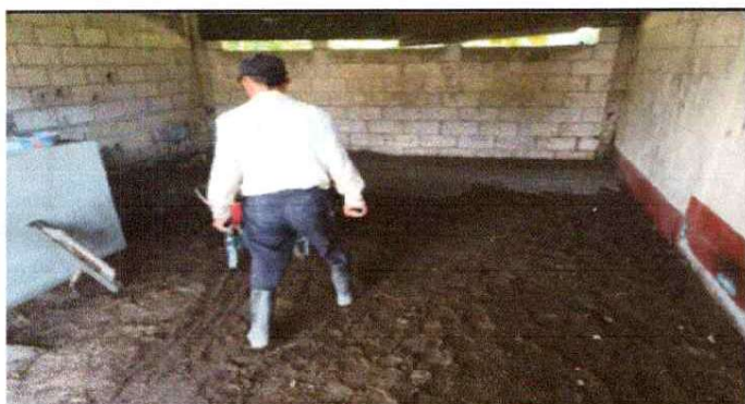
Foto 3: Sustitución de piso de concreto
