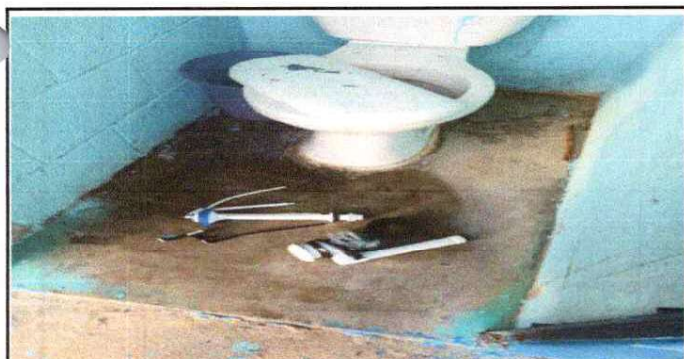
Foto 5: Sustitución de Baños
