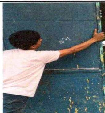
Foto 2: Sustitución de puerta
