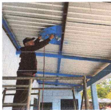
Mantenimiento a estructura de soporte de metal
