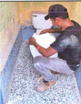
Sustitución de baño
