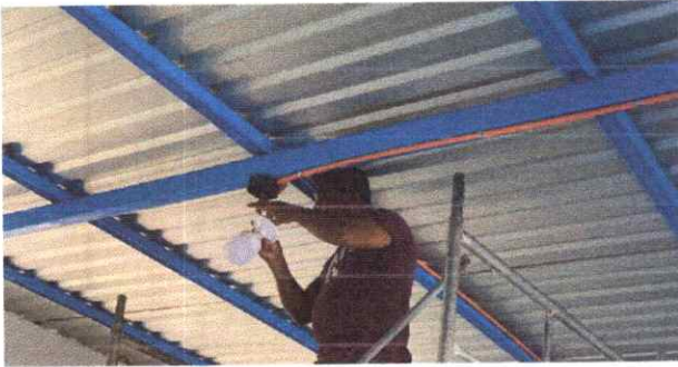
Sustitución de focos ahorradores
