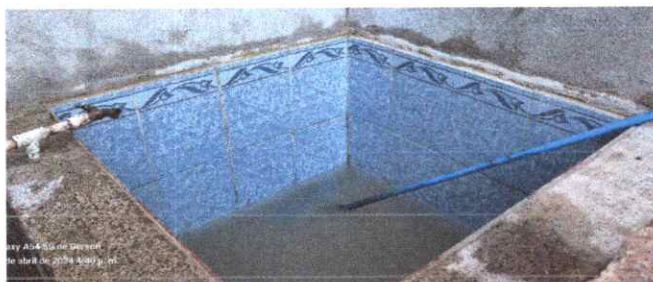
Reparación de cisterna de concreto
