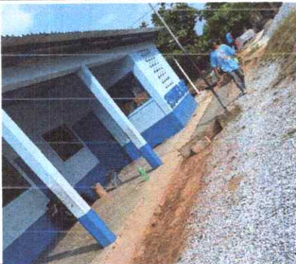
Reparación de cuneta de concreto
