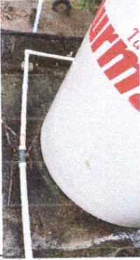
Sustitución de tubería principal
