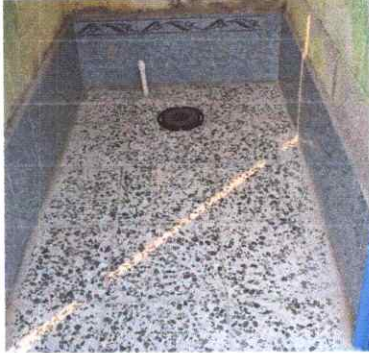
Sustitución de cerámico
