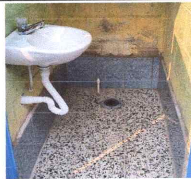
Sustitución de lavamanos
