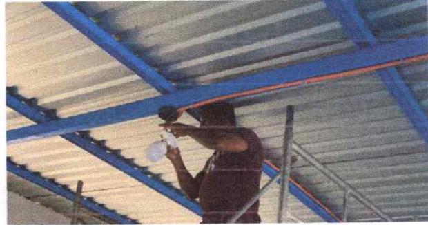
Sustitución de plafoneras
