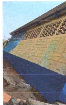
Pintura de muros exteriores e interiores
