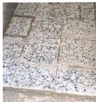
Reparación de piso cerámico
