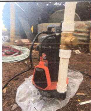
Sustitución de bomba de agua
