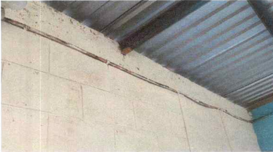
Sustitución de ducto eléctrico + accesorios
