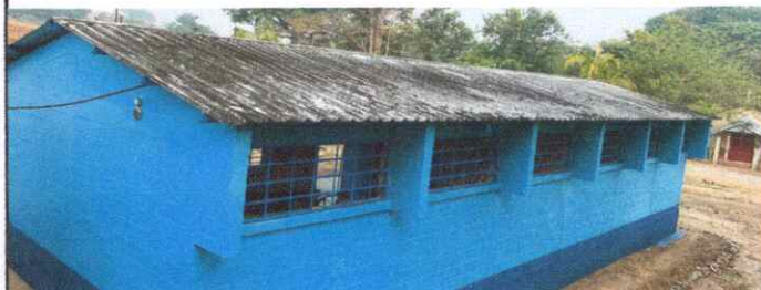
Sustitución de canales de pvc se sustituye a pintura de techo de dos aulas según acta No. 10-2024
