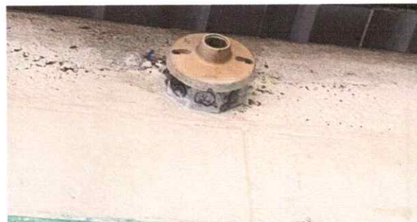
Sustitución de plafoneras
