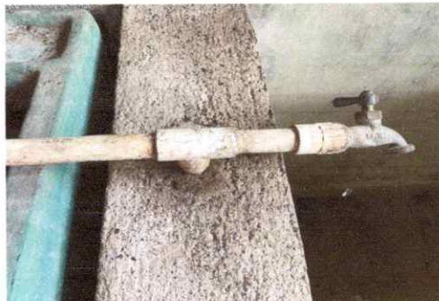
Sustitución de llaver de chorro
