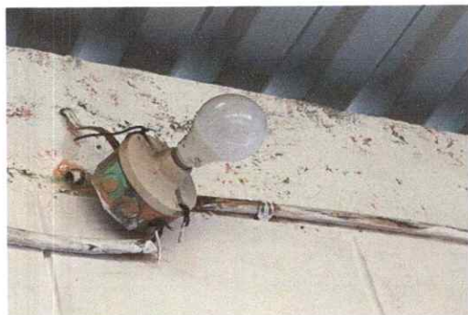
Sustitución de focos ahorradores
