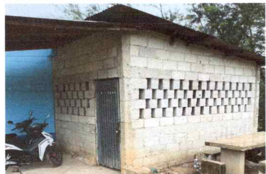
Repello en muro
