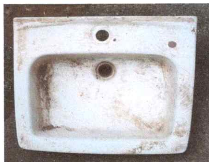
Sustitución de lavamanos
