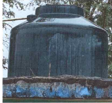
Sustitución de depósito de agua 1100 lt
