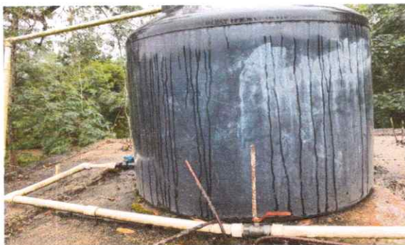
Sustitución de tubería principal
