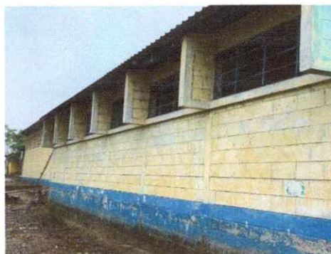
Pintura de muros exteriores e interiores
