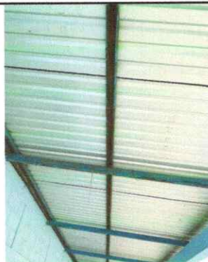
Mantenimiento a estructura de soporte de metal
