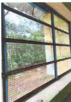
Mantenimiento a estructura de metal de ventana
