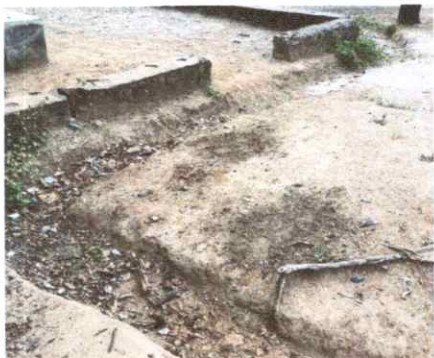
Reparación de cuneta de concreto
