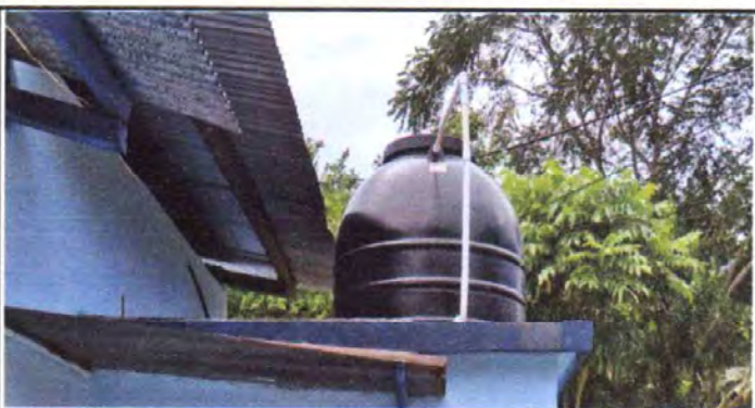
Foto No. 11. Sustitución de depósito de agua 1100 lt.
