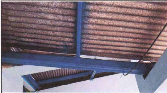
Foto 1. Mantenimiento a estructura de soporte de metal
