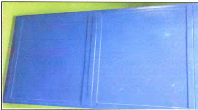
Foto 3. Sustitución de Ventanas de madera por metal
