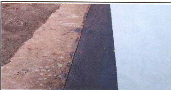
Foto 5. Reparación de banquetas de concreto
