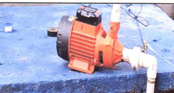
Foto No. 12. Sustitución de bomba de agua
