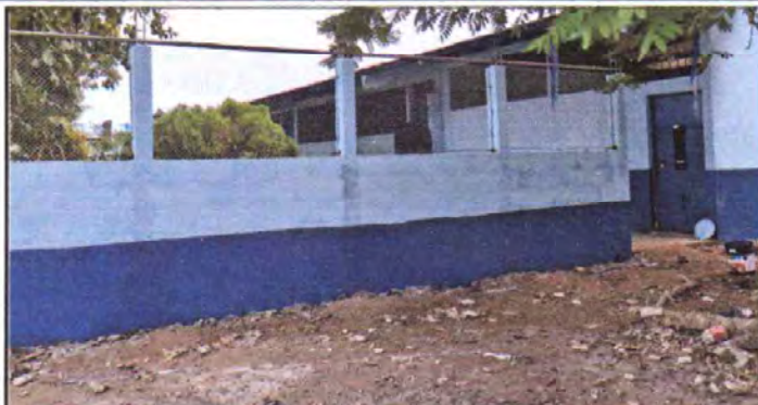
Foto No. 8. Reparación de muro perimetral de block con tubo y malla galvanizada, soleras intermedias y columnas
