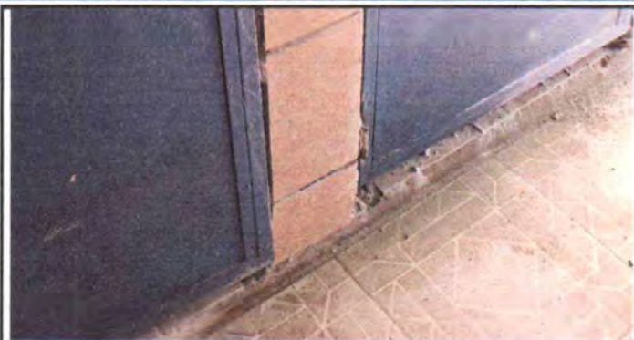
Foto No. 7 Reparación o sustitución de azulejos
