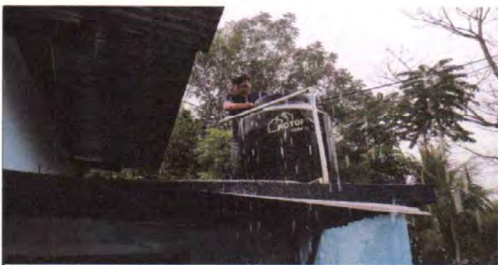
Foto No. 11. Sustitución de depósito de agua 1100 lt.
