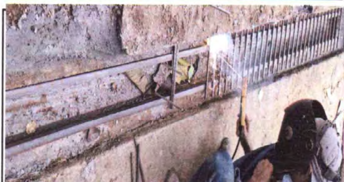
Foto 4. Reparación de cuneta de concreto
