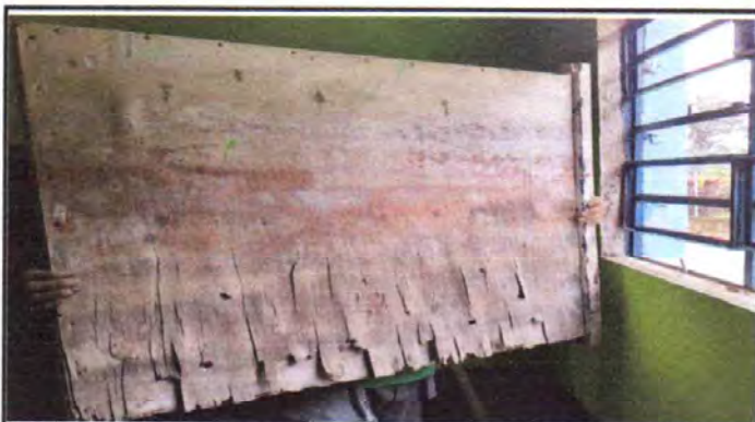
Foto 3. Sustitución de Ventanas de madera por metal
