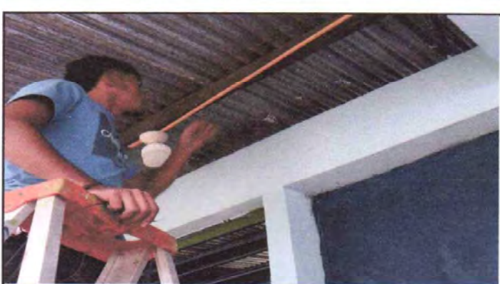
Foto No. 10. Sustitución de ducto eléctrico más accesorios
