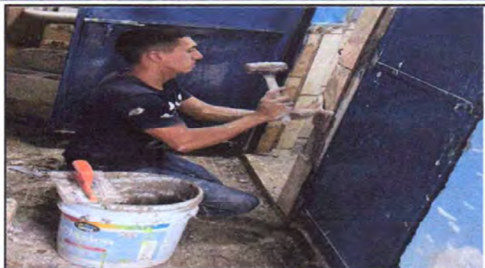
Foto No. 7 Reparación o sustitución de azulejos
