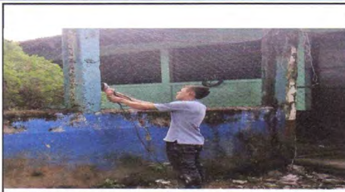
Foto No. 8. Reparación de muro perimetral de block con tubo y malla galvanizada, soleras intermedias y columnas
