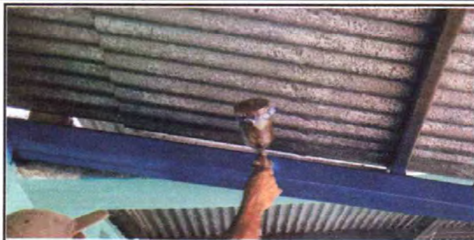
Foto 1. Mantenimiento a estructura de soporte de metal
