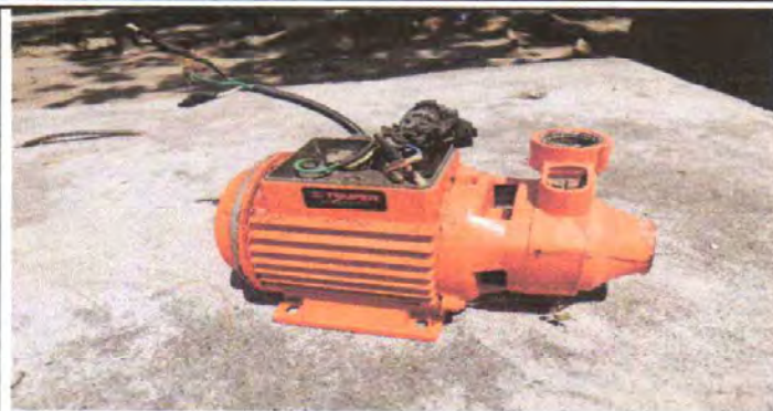
Foto No. 13. Sustitución de bomba de agua
