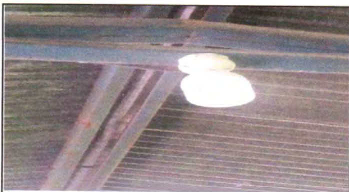
Foto No. 10. Sustitución de lámpara tipo Led
