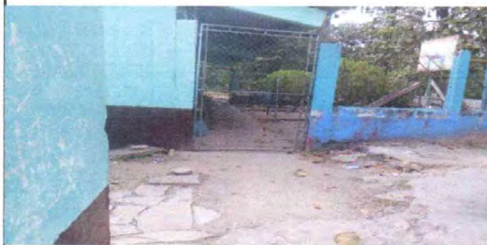
Foto No. 7. Pintura en muros exteriores e interiores
