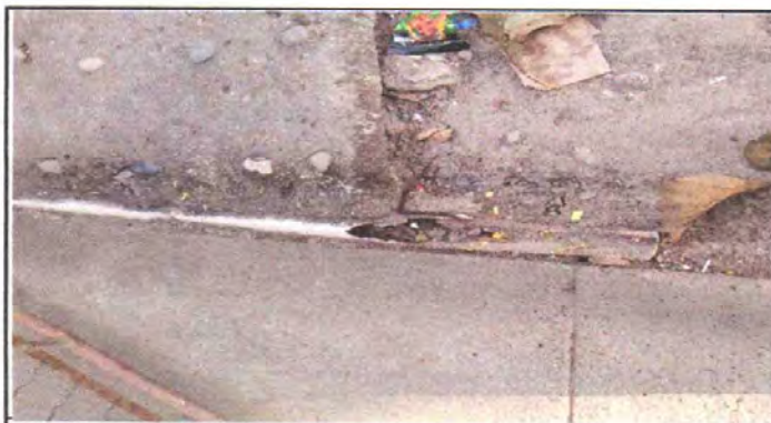
Foto 5. Reparación de cuneta de concreto
