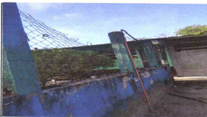
Foto No. 9. Reparación de muro perimetral de block con tubo hg y malla galvanizada, soleras intermedias y columnas
