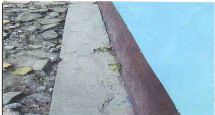
Foto 6. Reparación de banquetas de concretos
