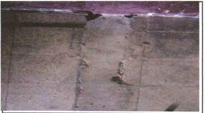
Foto 4. Sustitución de piso de granito
