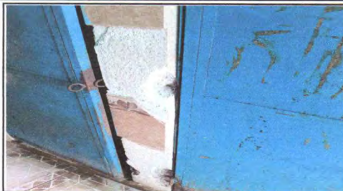
Foto No. 8. Reparación o sustitución de azulejos
