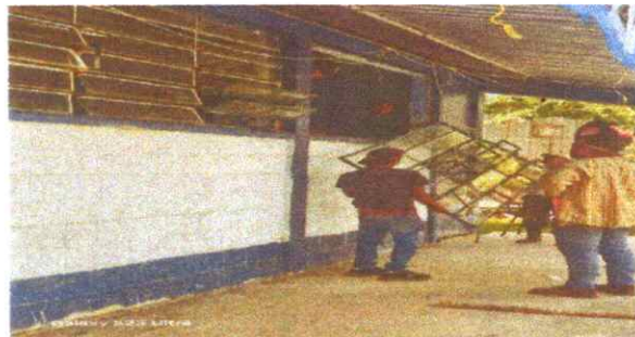
Foto 4: Sustrucción de estructura de metal de ventana
