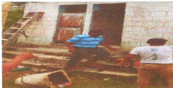
Foto 3: Mantenimiento de estructura
