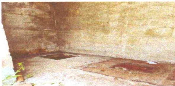
Foto 5: Sustrucción de inodoros
