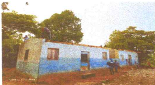
Foto 1: Sustrucción de lámina, por lámina aluzinc
