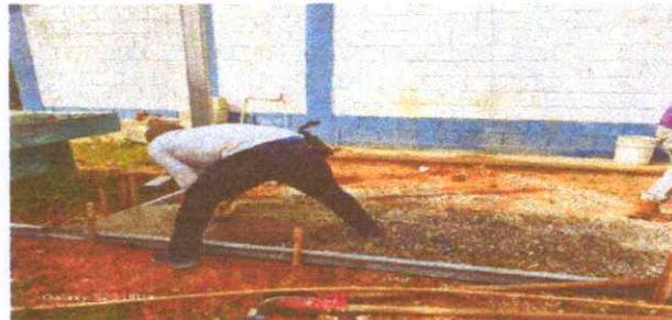
Foto 6: Reparación de piso de torta de concreto
