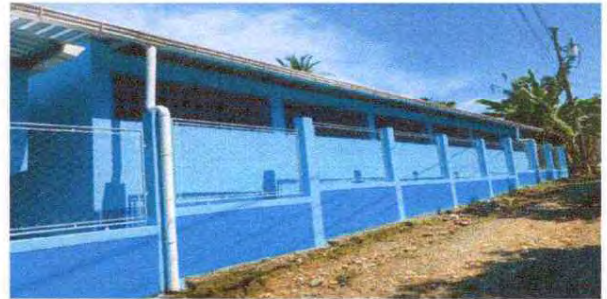
Foto 4. Pintura en muros exteriores e interiores
