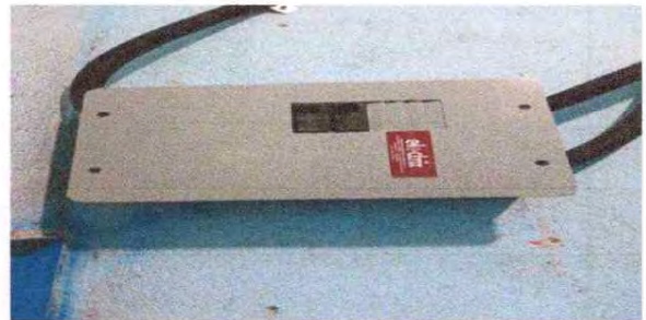
Foto 10. Sustitución de flujos
