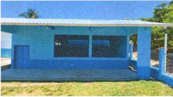
Foto 1. Sustitución de lamina por lamina troquelada
