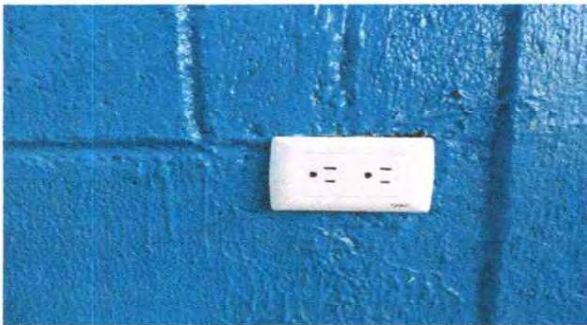
Foto 9. sustitución de tomacorriente doble
