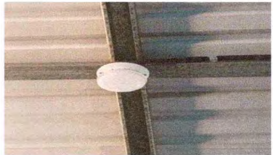
Foto 6. Sustitución de lamparas
