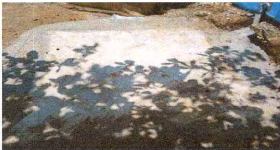
Foto 5. Sustitución de tubería pvc línea principal de aguas negras
