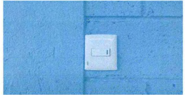
Foto 8. Sustitución de interruptores
