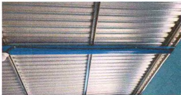
Foto 13. Sustitución de ducto y sus accesorios
