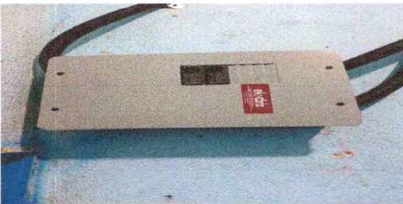
Foto 11. Sustitución de tablero
