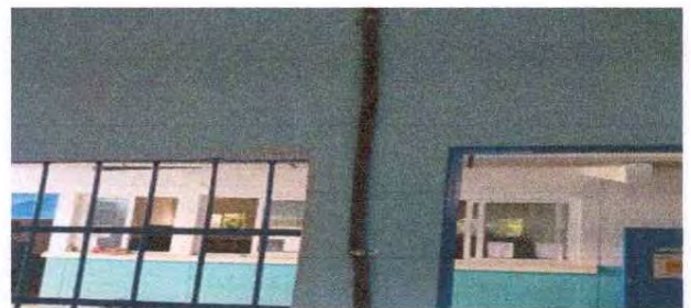
Foto 12. Sustitución de cableado eléctrico
