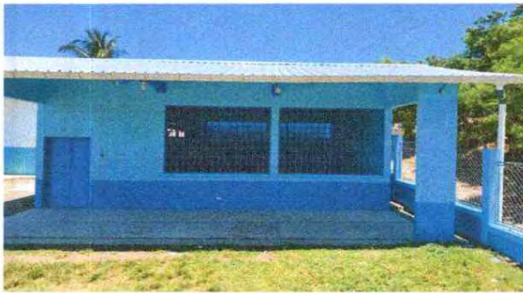
Foto 3. Sustitución de canales pvc por pvc y bajadas de agua pluvial
