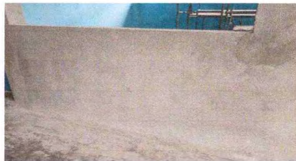
Foto 16. Repello en muros y paredes
