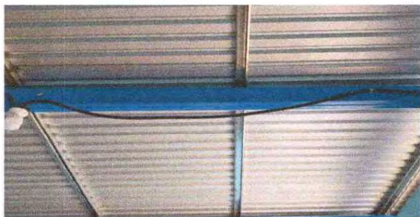
Foto 13. Sustitución de ducto y sus accesorios
