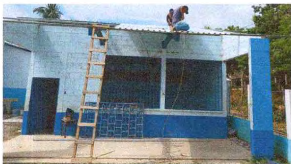
Foto 1. Sustitucion de lamina por lamina troquelada
