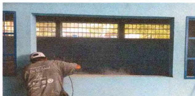
Foto 14. Sustitución de balcones y ventana
