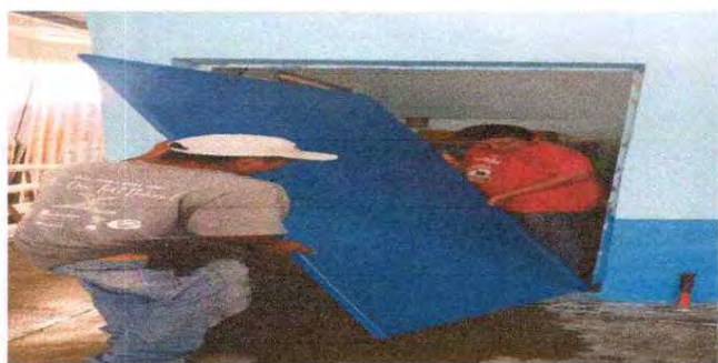
Foto 15. Sustitución de puerta de metal en módulos
