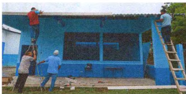
Foto 3. Sustitucion de canales pvc por pvc y bajadas de agua pluvial
