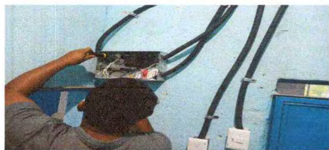
Foto 11. Sustitucion de tablero
