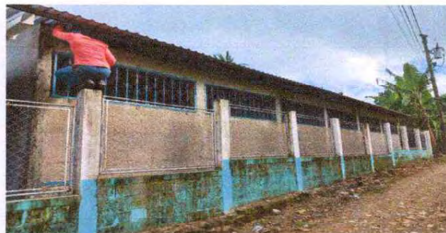
Foto 4. Pintura en muros exteriores e interiores
