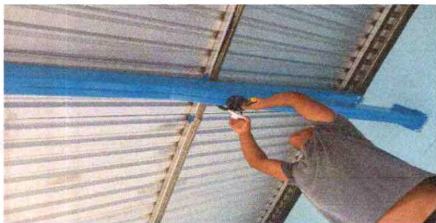
Foto 7. Sustitucion de plafonera
