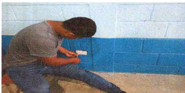
Foto 9. sustitucionde tomacorriente doble
