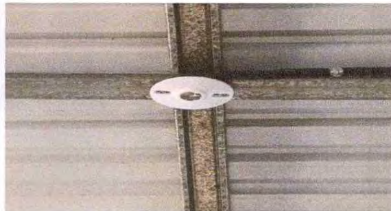
Foto 6. Sustitucion de lamparas
