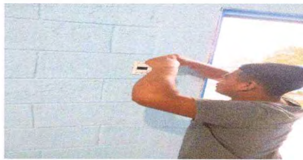
Foto 8. Sustitucion de interruptores
