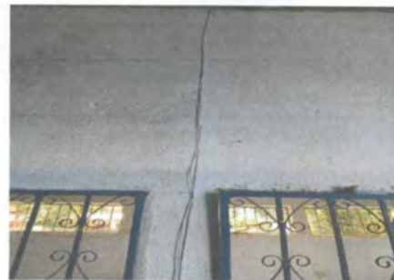
Foto 12. Sustitucion de cableado electrico
