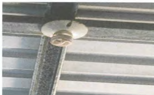
Foto 6. Sustitucion de lamparas
