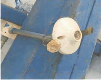
Foto 7. Sustitucion de plafonera
