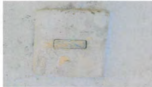
Foto 8. Sustitucion de interruptores
