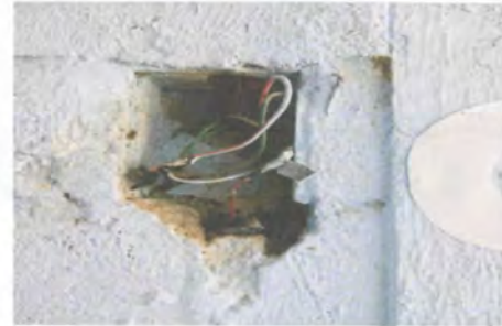
Foto 10. Sustitucion de flipones
