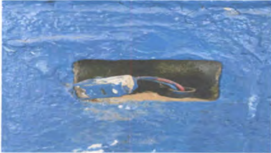
Foto 9. sustitucionde tomacorriente doble
