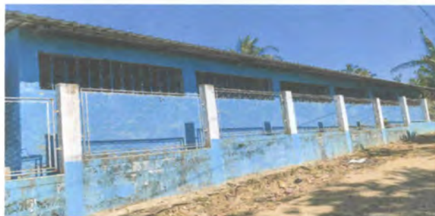
Foto 4. Pintura en muros exteriores e interiores
