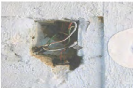
Foto 11. Sustitucion de tablero
