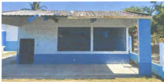
Foto 1. Sustitucion de lamina por lamina troquelada
