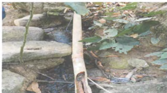
Foto 5. sustitucionde tuberia pvc libea principal de aguas negras
