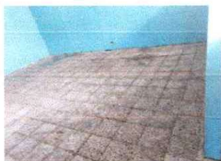
Sustitución de piso
