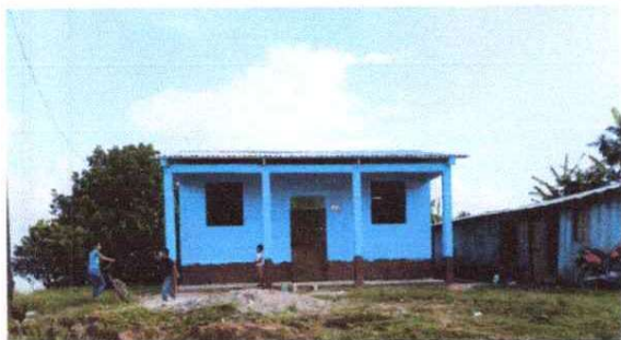
Sustitución lámina troquelada de zinc
