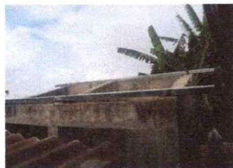
Sustitución de estructura de soporte de madera por meral
