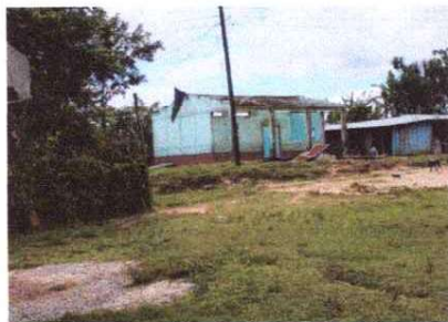
Sustitución lámina troquelada de zinc
