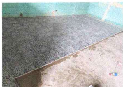
Sustitución de piso
