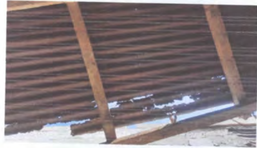
Sustitución Lámina troquelada de zinc
