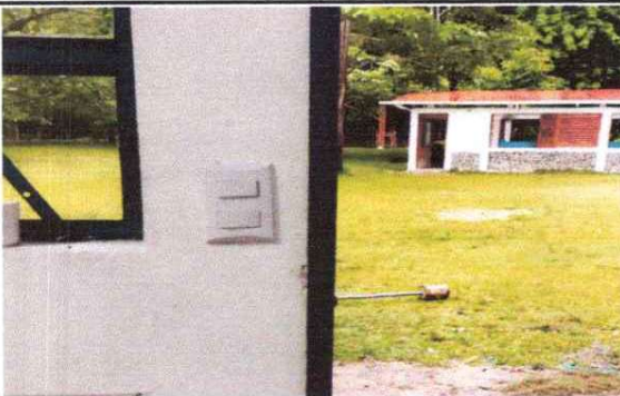
FOTO 5: Sustitucion de interruptores dobles.
