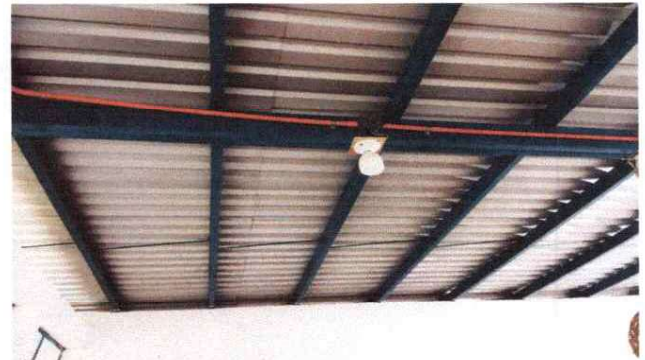
FOTO 4: Sustitución de lámparas tipo Led.
