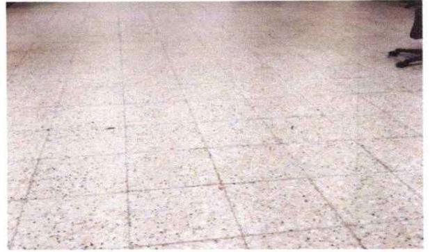
Foto 2: Sustitución de piso de torta de concreto a piso cerámico
