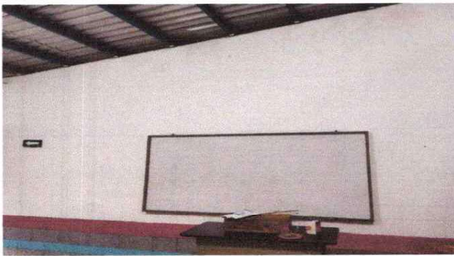
FOTO 3: Pintura en muros Exteriores e Interiores
