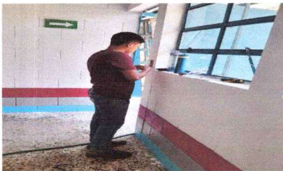
Foto 5: Sustitución de toma corrientes doble
