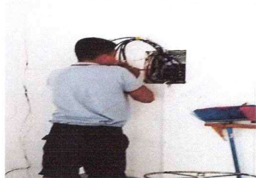
Foto 6: Sustitución de flipones
