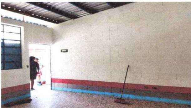
Foto 3: Pintura en muros exteriores e interiores
