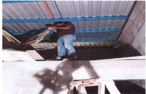
Foto 4: Sustitución de lamparas tipo Led
