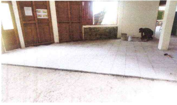
Foto 1: Sustitución de piso de torta de concreto a piso cerámico
