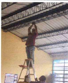
3. Deterioro de Sistema eléctrico.
